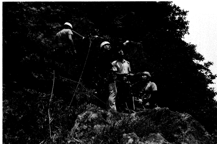
張り込み支点とウィンチ設置
